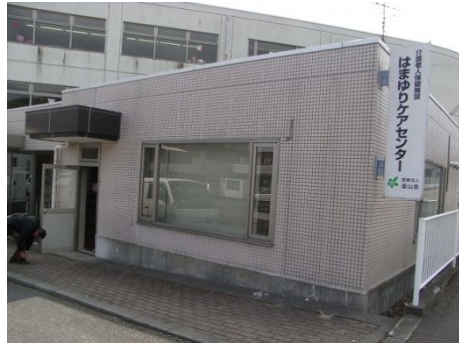
仮設HE設置場所(病院事務所)
