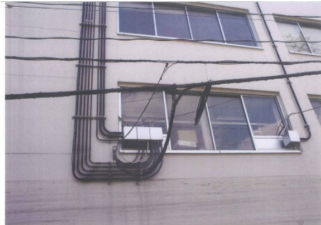
三陸ブロードネット(株)社屋からのケーブル配線部
