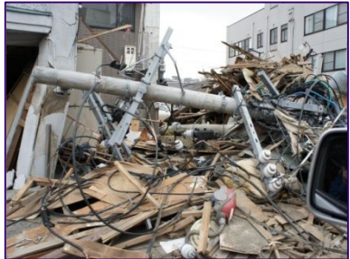
倒壊した電柱
